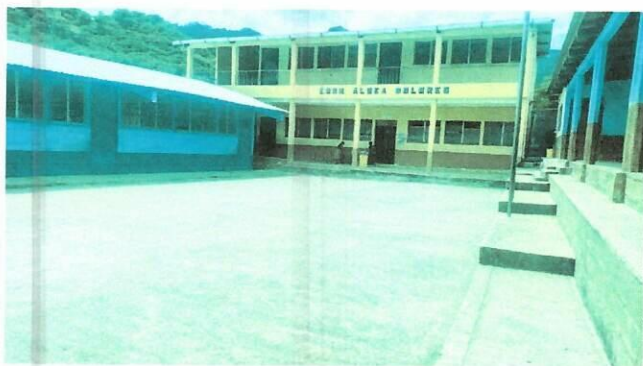
Foto 1: ÁREA DE REUNIONES DÓNDE SE NECESITA ESTRUCTURA TIPO PÓRTICO Y TECHO DE LÁMINA CALIBRE 26
